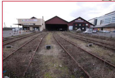
Paris 12 ème Site SNCF la halle Rapée Bercy Avant-projet Sogaris d'Hôtel logistique multimodal
