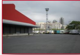
Paris 18 ème Site RFF de la cour Hébert Avant-projet Sogaris d'Hôtel logistique multimodal
